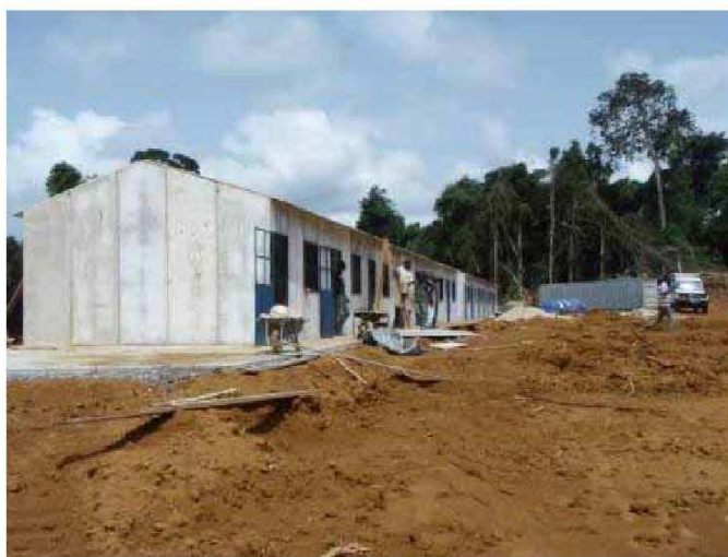
Un bâtiment en construction au camp CMEC près des Chutes Kongou
