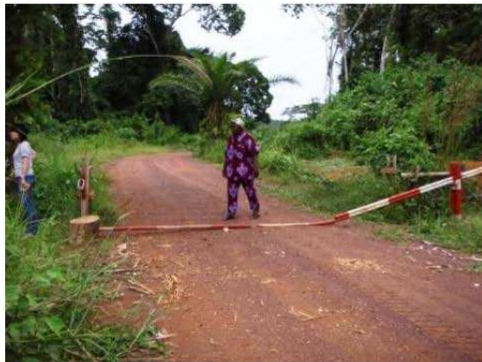
La barrière à l'entrée de la route CMEC est cassée
