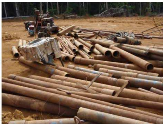
Matériels (tuyaux métalliques, groupes électrogènes etc.) au camp CMEC près des Chutes Kongou
