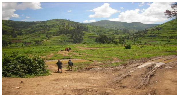
Photo n°2 : Vue de la zone sinistrée de Bigogwe à une période moins pluvieuse
