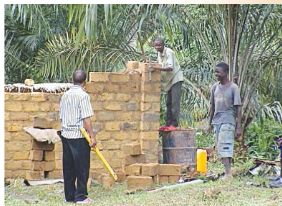
Construction d'un dépôt pour Carburant à Mondjoku, PNS © Omari Ilambu, WWF
