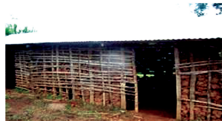
L' école primaire en voie de réhabilitation
